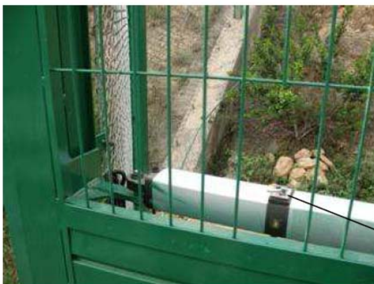
Dispositiu de desacoblament del motor (Girar a la dreta, una volta completa)
